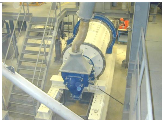
STABROHRMÜHLE SM 1220 "WALBURGA"
